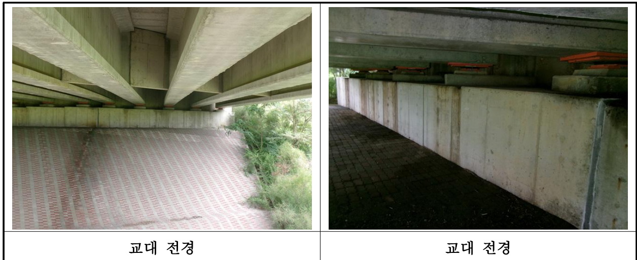
【사진 4.3.8】 교대 전경
