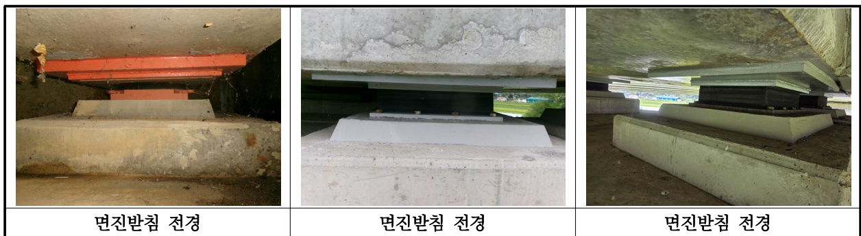
【사진 4.3.13】 교량받침 전경
