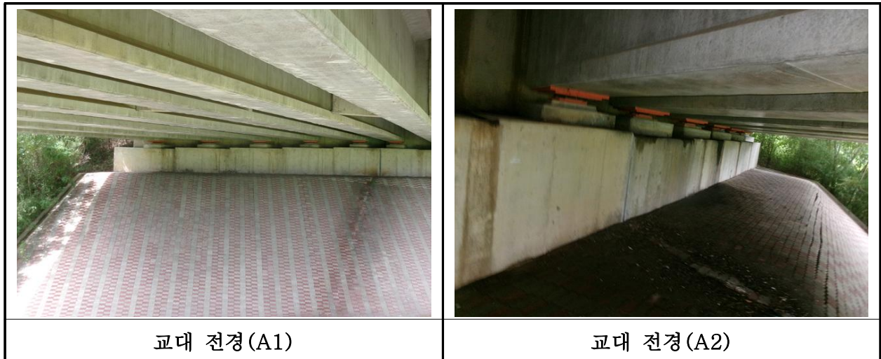
【사진 4.3.34】 교대 전경
