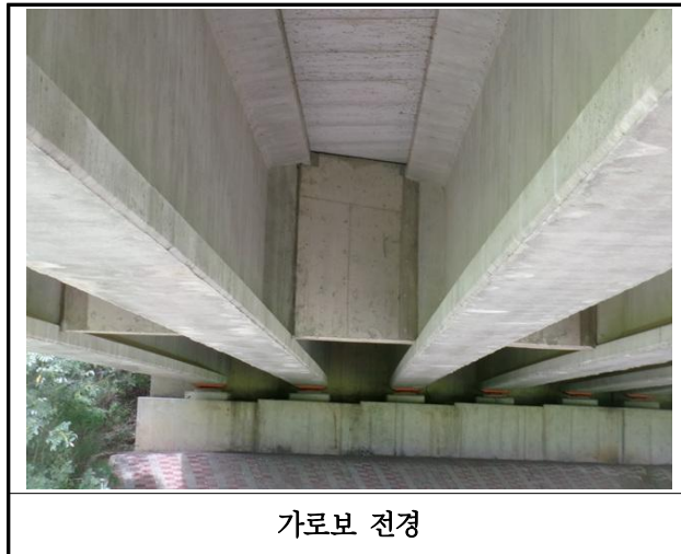
【사진 4.3.32】 가로보 전경
