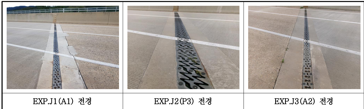
【사진 4.3.17】 신축이음장치 전경
