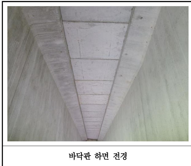
【사진 4.3.29】 바닥판하면 전경
