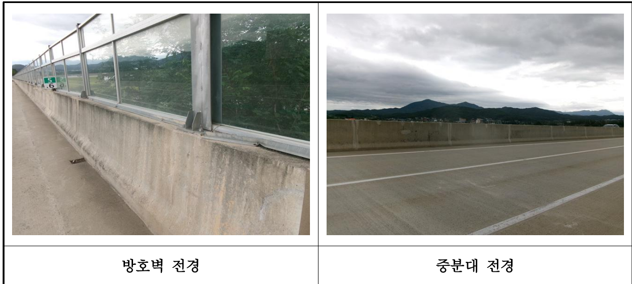
【사진 4.3.50】 방호벽 및 중앙분리대 전경
