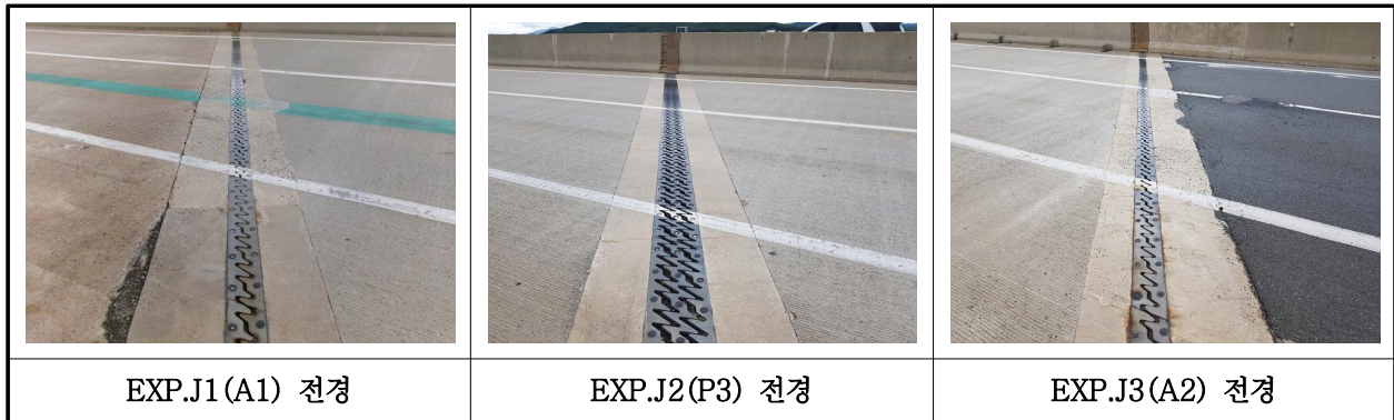
【사진 4.3.43】 신축이음장치 전경
