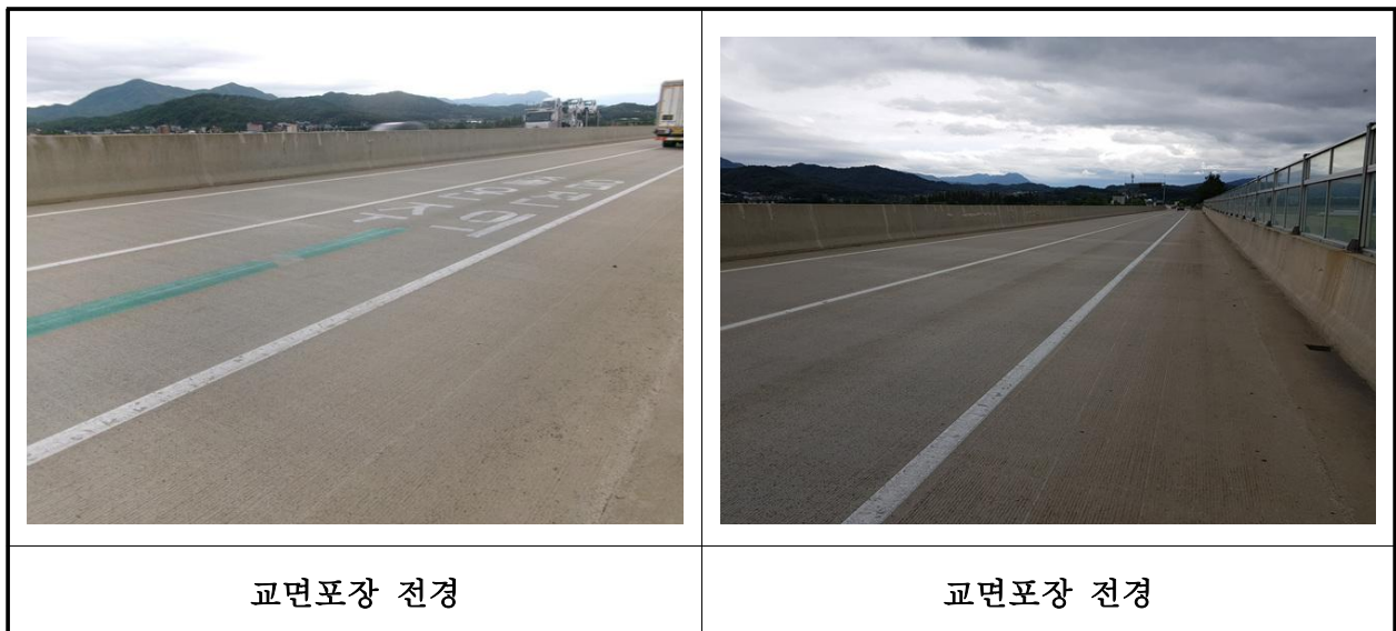
【사진 4.3.46】 교면포장 전경
