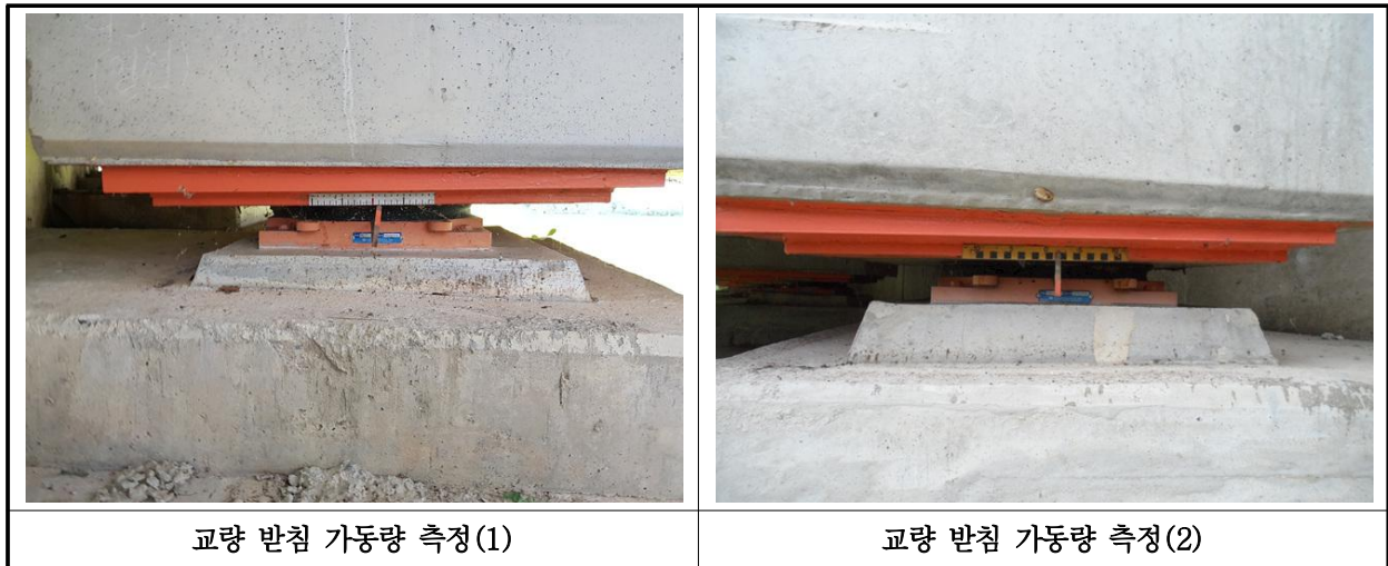
【사진 4.3.42】 교량받침 이동량 측정
