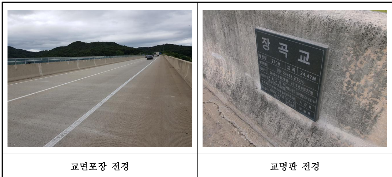
【사진 4.3.20】 교면포장 전경
